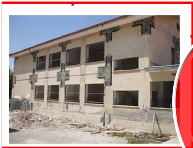
L'intervento in facciata rappresenta il catalizzatore del processo di intervento a causa di spesso improrogabili necessità legate al degrado ed al distacco di porzioni non strutturali
